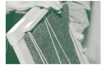
Das Schafwollvliese verschwindet hinter den seitlich angebrachten Holzleisten
